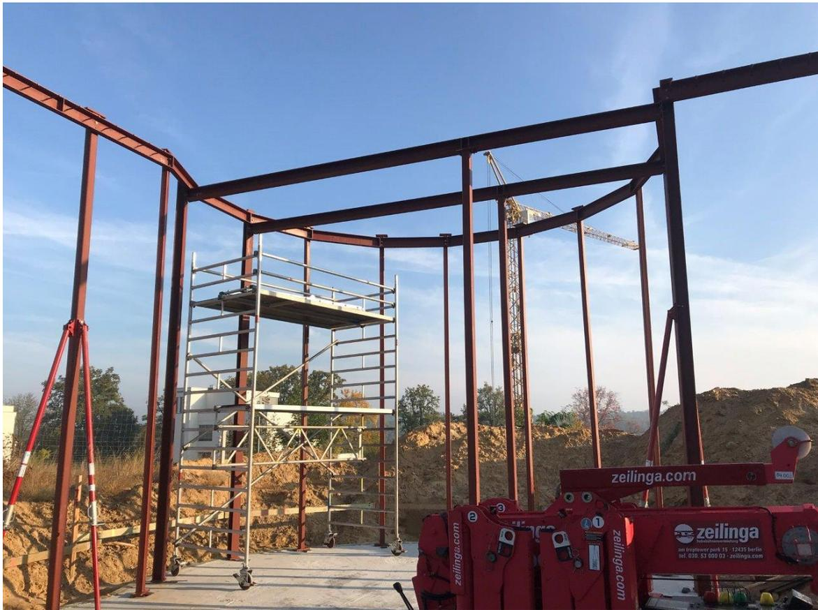
„Stahl vs. Stein“ - eine schlanke Stahlkonstruktion ersetzt massive Steinwände und ermöglicht somit schlanke und hochisolierende Außenwände.
