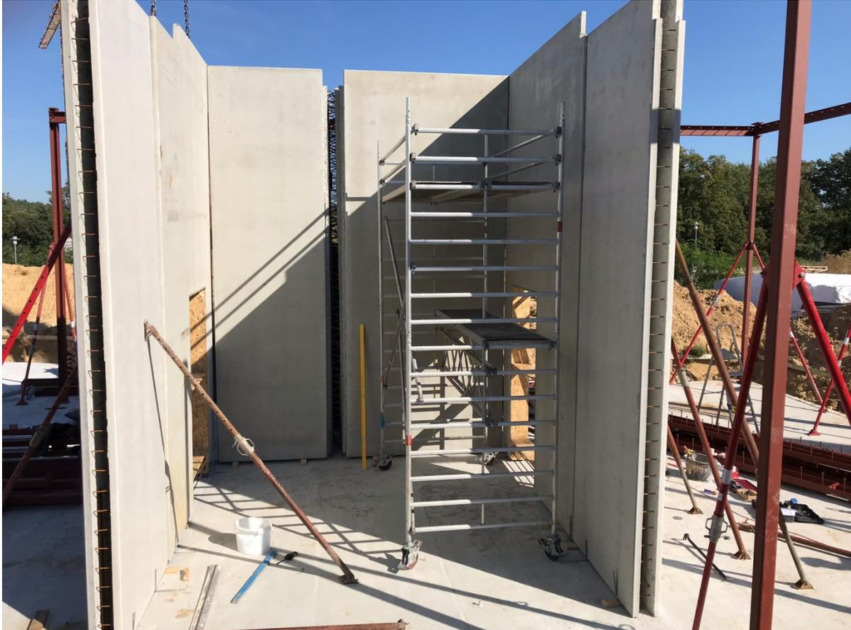
Das Treppenhaus ist der stabilisierende Kern der Stahlkonstruktion. Zusammen mit den Geschosdecken ergibt sich ein Speichervolumen von 133 m<sup>3</sup>.
